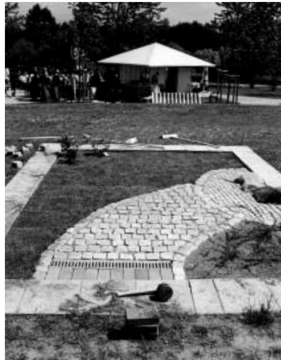
Gelöste Bauaufgabe in Wismar
