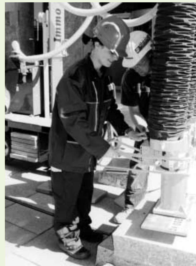
Schülerin Sandra Dengel packt kräftig an bei der Verlegung der 160 Kilogramm schweren Granitplatten. Fachliche Unterstützung kommt von Mathias Günther (Firma Herbst).
