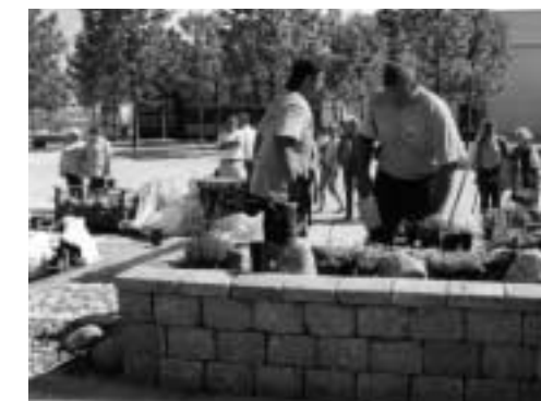
Martin Anton (links) und Markus Werle bei der Fertigstellung ihrer Bauaufgabe auf der IGA Rostock
