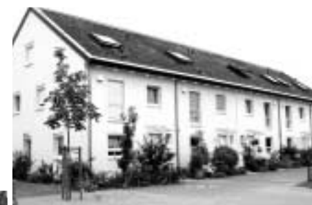
In Rüsselsheim wurden aufgrund städtischer Vorgaben in einer Neubauesiedlung sämtliche Schrägdächer mit einer extensiven Dachbegrünung versehen
