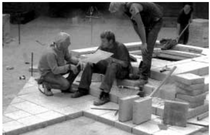
Bayerisches Learning by Doing: Azubis auf der Baustelle
