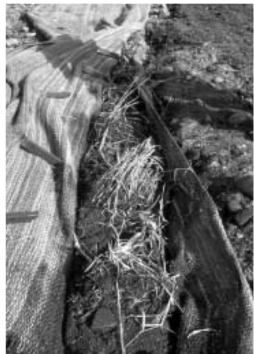
Röhrichtwalze im Bau (Abb. 6)
