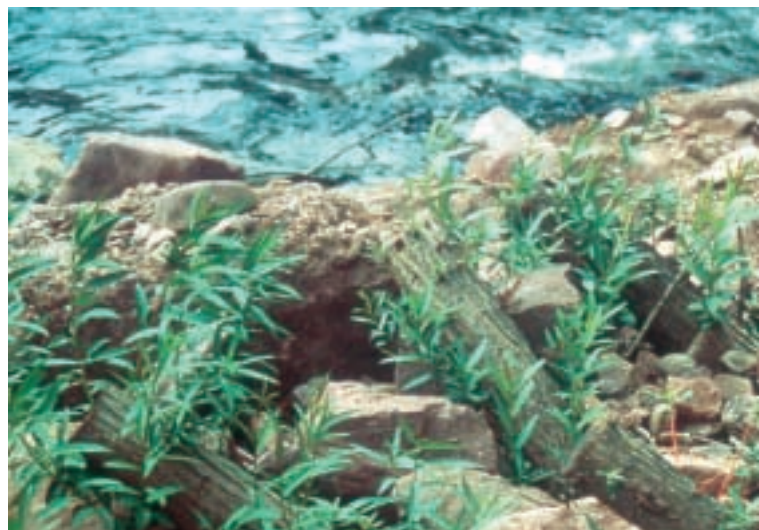
Steckholzaustrieb aus Steinwurf (Abb. 3)
