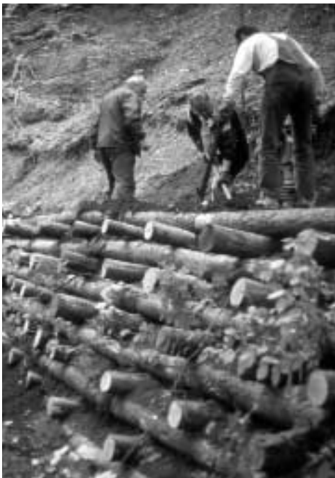
Holzgrüenschwelle im Bau (Abb. 5)
