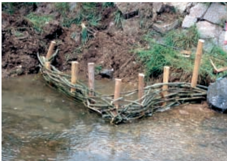
Flechtzaun zur Herstellung einer Flechtwerksbuhne (Abb. 1)
