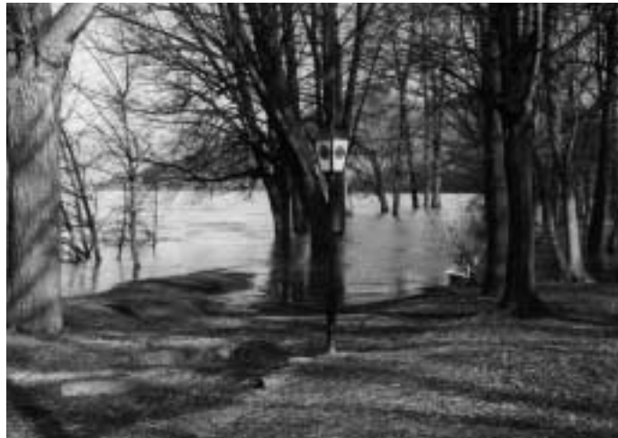
Offene Retentionsräume sind nicht immer wasserführend. Sie halten Regen- und Oberflächenwasser zurück und vermindern Hochwasser.
