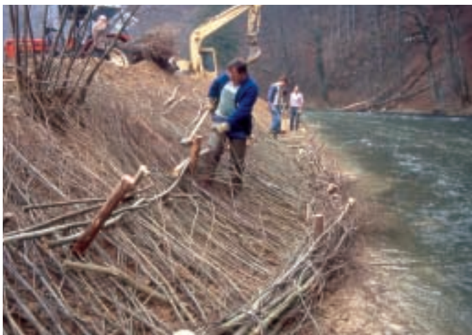
Weidenspreitlage mit Uferfaschine (Abb. 2)
