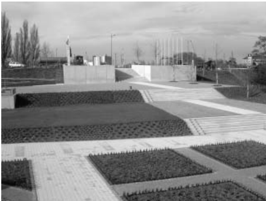
Kurz vor der Fertigstellung: die Landesgartenschau Kehl & Strasbourg.
