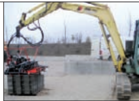
Pflastern mit Optima
