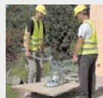
sollte schon heute mit der gesundheitsschonenden Vakuum-Verlegetechnik schwere Beton- und Natursteinplatten (bis 2.500 kg), Trittstufen, Bordsteine, Bauelemente etc. verlegen.
