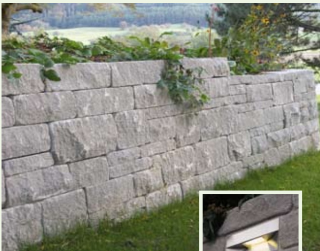
Die blendfreien Einbauleuchten und andere Elektroartikel sind auf die Kombination mit SANTURO®-Mauern abgestimmt.
