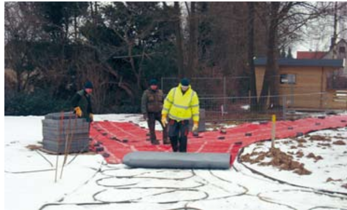
Roter Teppich für die Landesgartenschau in Bad Essen: Mitarbeiter des GaLaBau-Unternehmens Boymann GmbH & Co. KG nahmen eine Flächenheizung auf dem Gelände des Soleparks in Betrieb, um trotz Minustemperaturen den Wegebau fortsetzen zu können.
