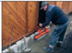
Schonendes Heben mit Vakuumtechnik
