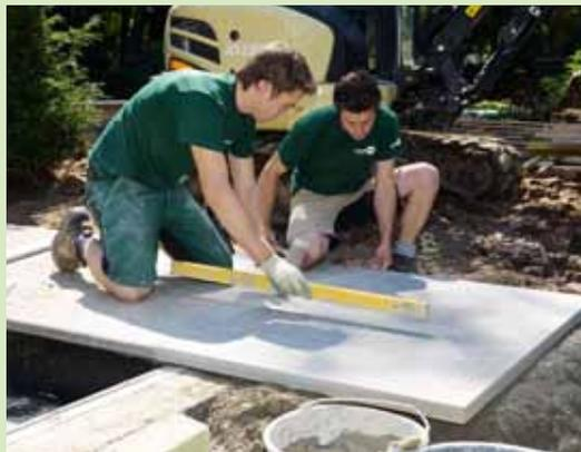
Das Verlegen der großen Natursteinplatten erfordert Präzision. Da prüft Bauleiter Sven Sagasser (r.) gern schnell noch mal nach, ob alles passt.
