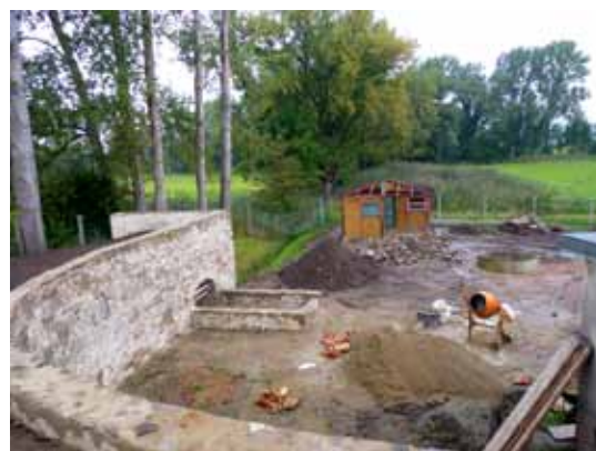
Die Eckstein & Sommer GmbH Garten und Landschaftsbau sanierte die Quelle Spring mit Brunnen, Pumpenhaus, Versorgungshäuschen und über 500 Meter Wegen.
