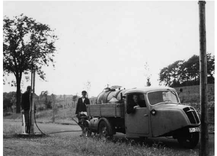
Das historische Foto aus dem Jahr 1926 zeigt Mitarbeiter des Unternehmens Leonhards bei Pflanz- und Bewässerungsarbeiten an einer Landstraße.
