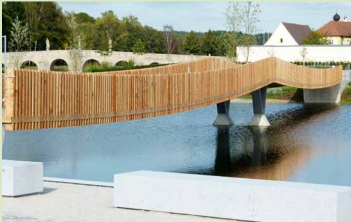
Über das Wasser gehen: Einzigartig in Europa ist die neu gebaute Spannbandbrücke, die zum Fischhof führt.
