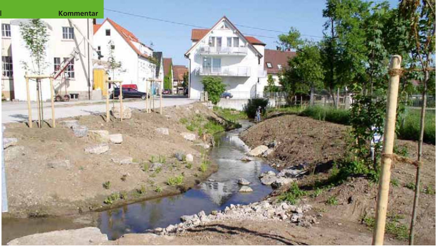
Neben großflächigen Vegetationsprogrammen sind auch viele kleinere ingenieurbio-logische Baumaßnahmen vor Ort nötig, um einen wirksamen Hochwasserschutz zu erreichen – wie hier bei der naturnahen Umgestaltung des Rankbachs in Renningen, Bereich Mühle Sessler.
