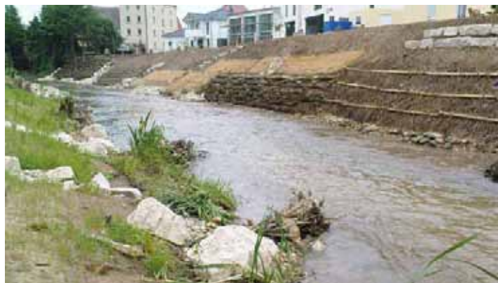
Die naturnahe Umgestaltung von Fließgewässern ist ein wirksamer vorbeugender Hochwasserschutz. Die Lauter in Kirchheim hat durch die Umgestaltung mehr Platz bekommen, die Fließgeschwindigkeit wurde reduziert.
