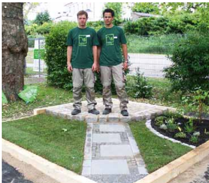
Endlich geschafft! Tim Bracht (r.) und Christoph Jacobs präsentieren stolz ihr fertiges Bauwerk.
