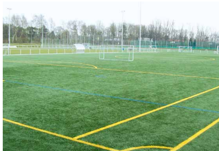
Für Kunststoffflächen und -rasenflächen im Sportplatzbau sind die DIN-Normen grundlegend überarbeitet worden. Foto: STRABAG Sportstättenbau GmbH, Dortmund
