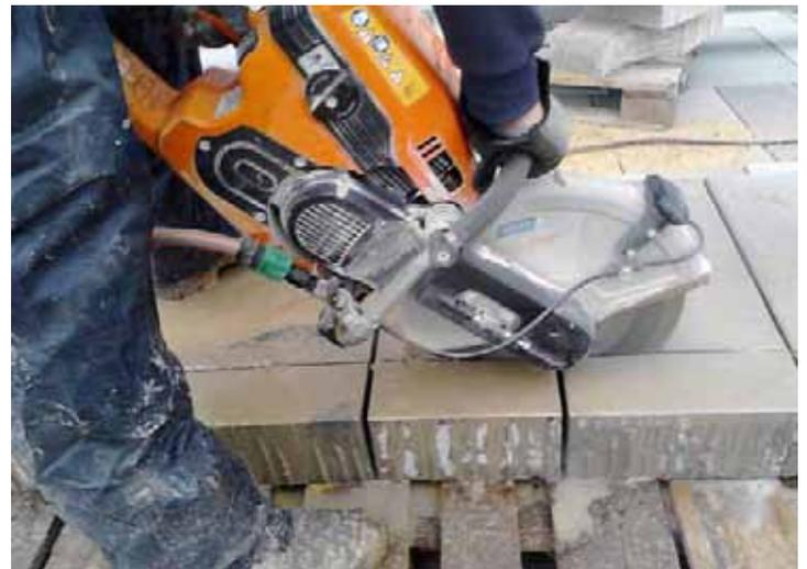
Der handgeführte Trennschleifer T350i im Einsatz.
