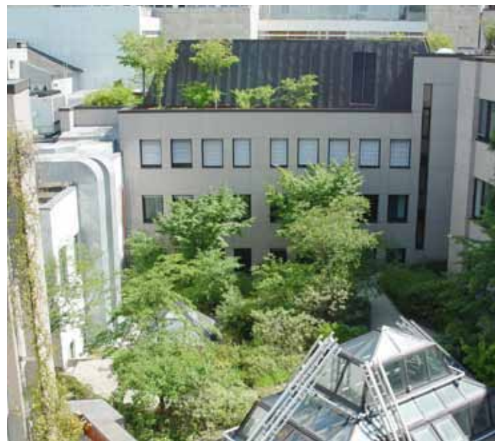
Ein intensiv begrüntes Dach in der Stadt: Selbst Bäume finden hier einen Platz in luftiger Höhe. Rankhilfen (l.) geben außerdem Gerüstkletterpflanzen Halt und sorgen dafür, dass sich das Grün an der Fassade fortsetzt.
