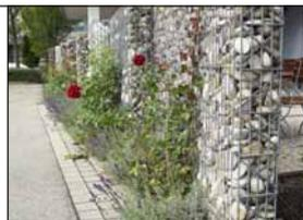
Durch die von Rothfuss entwickelte spezielle Drahtgitterkonstruktion besteht ein Blicks-Grundkorb grundlegend aus nur 2 Seitengittern, zwei Frontgittern und einem Deckelgitter. Dabei kann man bei den Seitengittern zwischen einer Dübel- oder Betonversion wählen.
