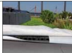
Der Abstandshalter (Spacer) von ZinCo eröffnet Raum für die Wasserspeicherung
