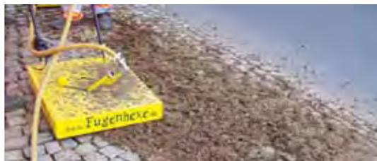
Sanierung leicht gemacht: Die Fugenhexe von Optimas räumt Fugen per Druckluft aus.
