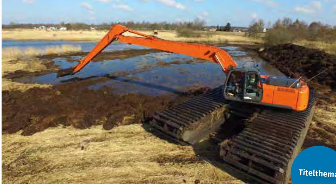
Bei Boden im Konsistenzbereich ko3 kann die mechanische Belastung durch entsprechende Geräte so reduziert werden, dass die Arbeiten fortgeführt werden können.
