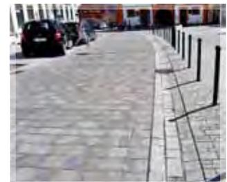
Mit der Produktlinie Primavera® haben Planer und Bauherren alle Optionen für eine technisch und optisch ausgereifte Gesamtlösung, die individuell an das architektonische Umfeld angepasst werden kann. Von 8 cm Pflaster- bis 12 cm Plattendicke – Formate von 12,5 x 12,5 bis 60 x 40 cm – von privat bis öffentlich – Primavera® verbindet Funktion und Ästhetik.
