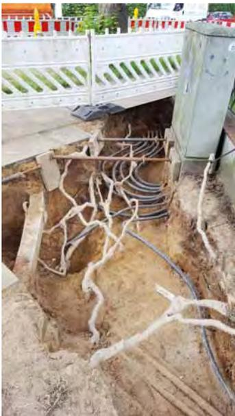
Der beauftragte Baumpfleger kümmert sich während der Bauphase um den Wurzelschutz der angrenzenden Straßenbäume. Das sensible Wurzelwerk wird behutsam freigelegt und zum Schutz mit Jute bandagiert.
