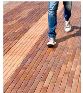
Das Leitsystem mit taktilen Bodenindikatoren fügt sich nahtlos in den Läuferverband der GIMA Pflasterklinker ein und ermöglicht blinden und sehingeschränkten Menschen kontrastreich die Orientierung.
