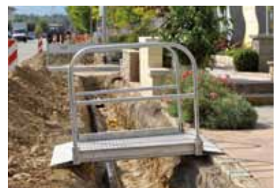
Gräben können mit einem Baustellensteg von Altec sicher überbrückt werden.
