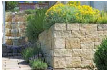
Gartensituation mit Santuro® Schichtmauerwerk
