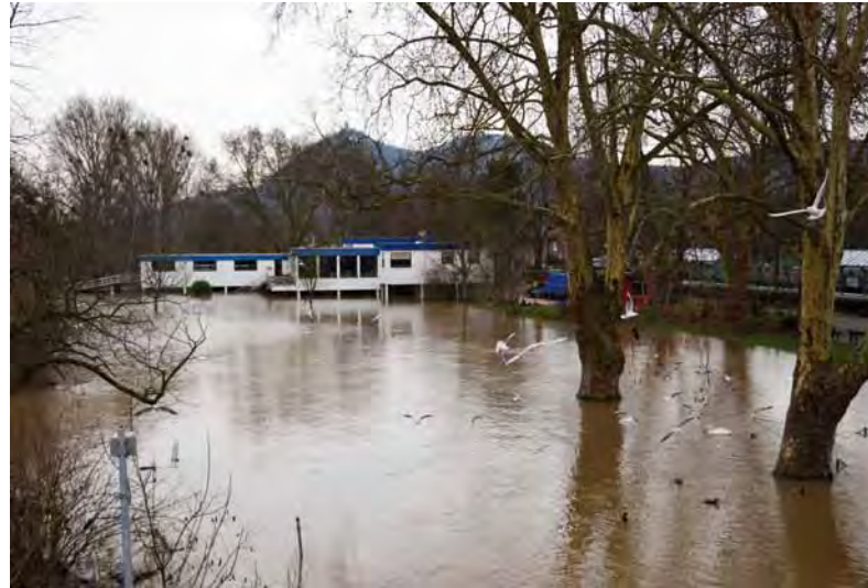
Hochwassersituation in Bad Honnef am 9. Januar 2018.
