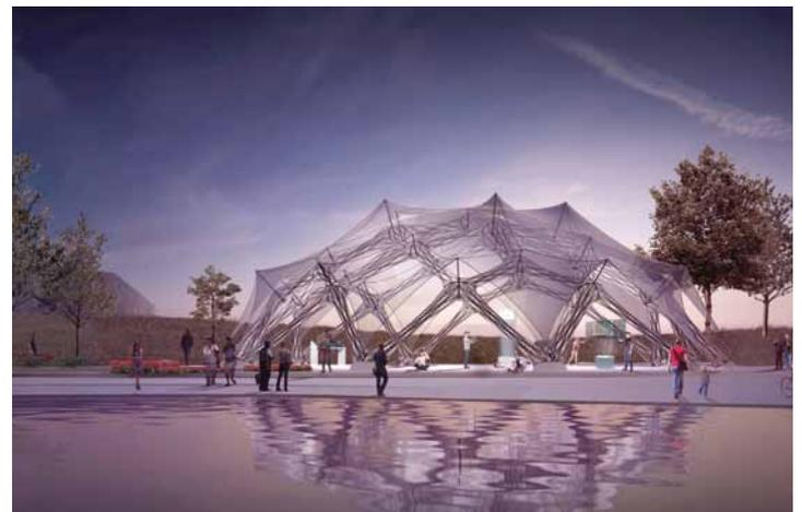
Die Tragstruktur des Faserpavillons besteht ausschließlich aus Glasfasern und Kohlestofffasern und wird in einem robotischen Fertigungsprozess hergestellt.
