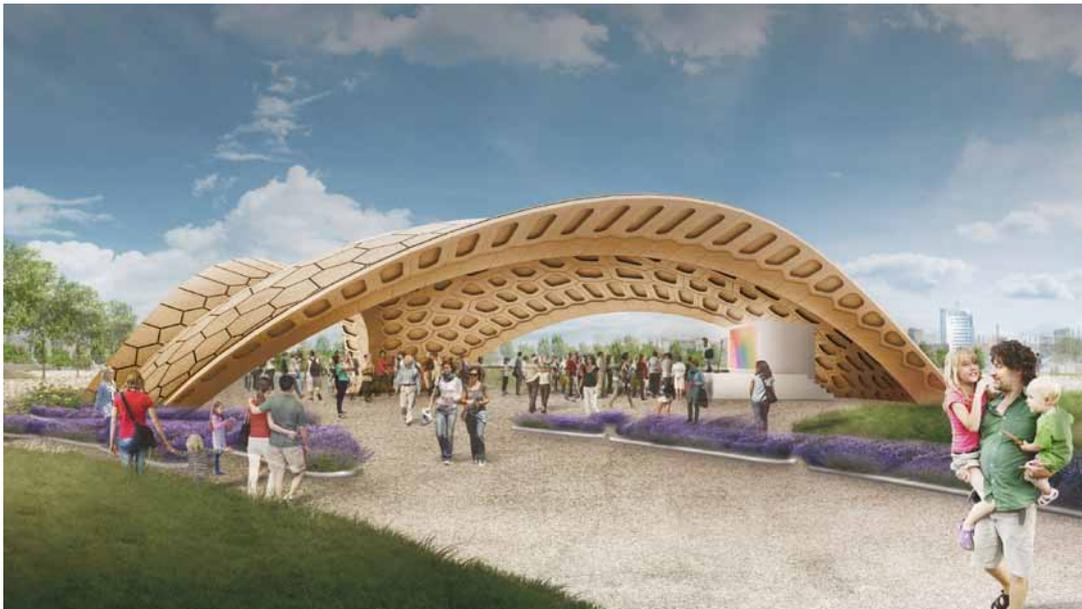
Das Institut für Tragkonstruktionen und Konstruktives Entwerfen der Uni Stuttgart baut einen Holzpavillon, deren Segmente nach Vorbildern aus der Natur konstruiert sind.
