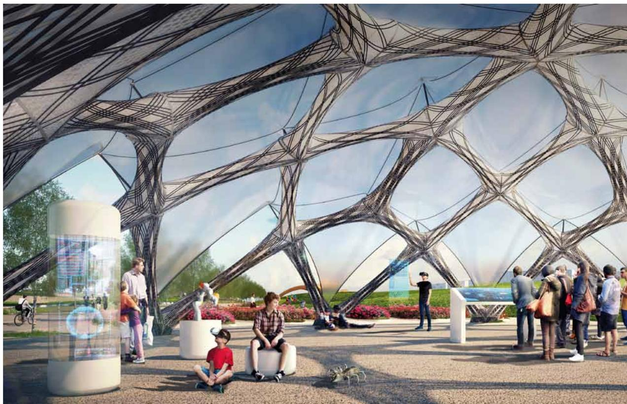
Im Vergleich zu technischen Systemen weisen biologische Strukturen in der Regel einen wesentlich höheren Grad an Leistungsfähigkeit und Materialeffizienz auf. Dies macht sich der Faserpavillon aus Glas- und Kohlestofffasern zunutze.
