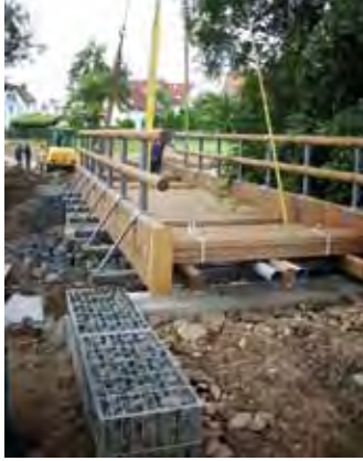
Komplett vormontiert wird die Holzbrücke auf die Baustelle geliefert.
