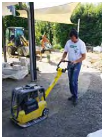
Axel Müller MdB bereitete den Boden für den Terrassenbelag auf einer Baustelle der Gartengestaltung Gropper vor.
