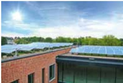
Das Optigrün „SolarGrünDach“ wird als auflastgehaltene System ohne Dachdurchdringung installiert.
