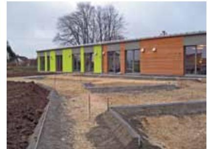
Bei befahrenen Wegen und Flächen werden die Metallprofile am besten in ein Streifenfundament gesetzt.
