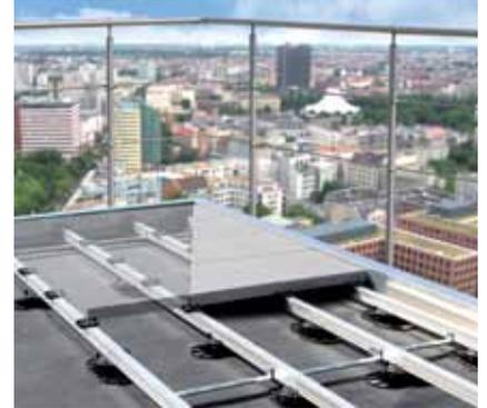
Dachterrassenbeläge sind schnell und stabil auf dem neuen Elefeet-Schienensystem verlegt. Foto: ZinCo
